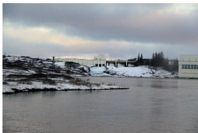
写真下：水力発電所(ウルフリョウスヴァトンにて)
