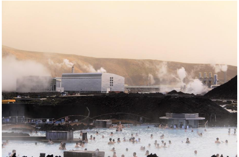
写真上：スヴァルスエインギ地熱発電所とブルーラグーン
